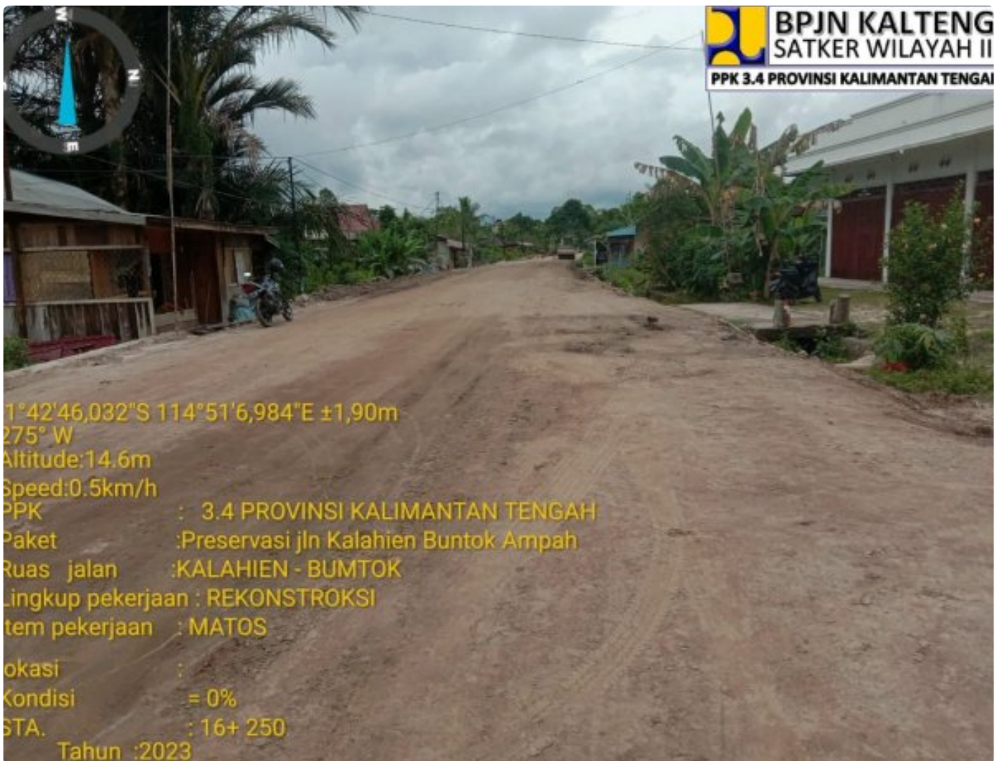
Gambar: Kondisi Terbaru Ruas Jalan Kalahien - Asam, Bontok.
